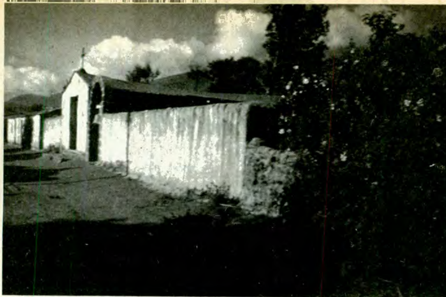
Poma Vieja, sector de la calle frente a la antigua iglesia, a cuyo costado están las dos campanas dañadas en el terremoto de diciembre de 1930.
